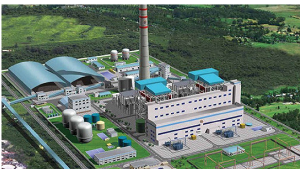
NHÀ MÁY NHIỆT ĐIỆN THÁI BÌNH 2 - THÁI BÌNH
