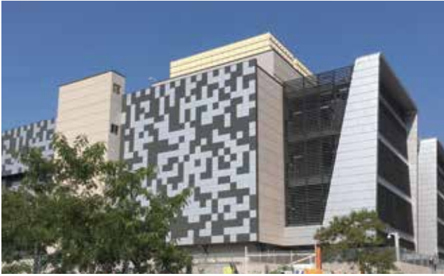
Trung tâm dữ liệu Global Switch / Hong Kong - Lắp đặt năm 2018
