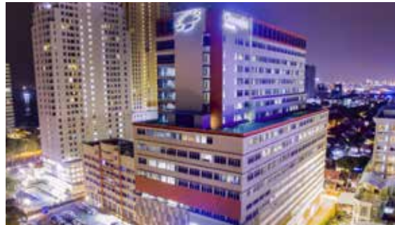
Bệnh viện Gleneagles Penang / Malaysia Lắp đặt năm 2024
