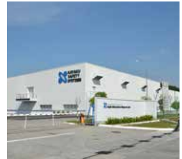
Kayaku Safety Systems / Malaysia Lắp đặt năm 2022
