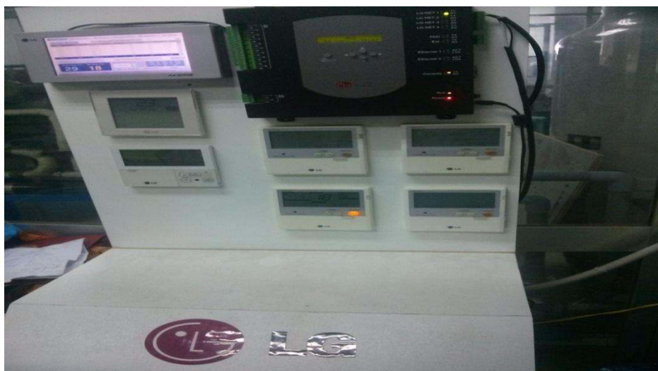
Hình 11: Hệ thống thiết bị điều khiển trung tâm hệ thống điều hòa Multi V III X6.15 IUH
